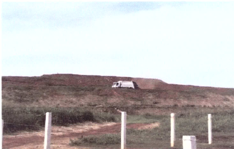
Foto: Talude em operação 2019
