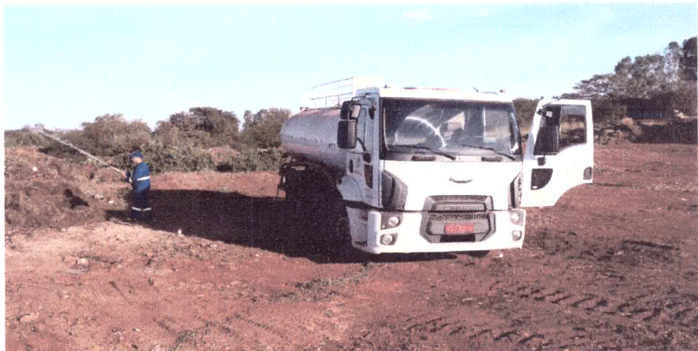
Foto: Monitoramento e medidas para reduzir risco de incêndio Poda/Capina 2019
