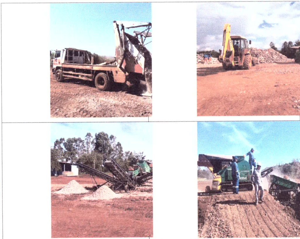
Foto: Processo de segregação e reciclagem do resíduo da construção civil 2019
