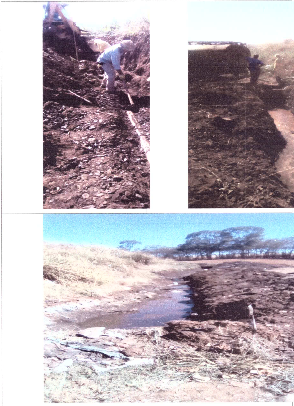
Foto: Desobstrução rede chorume 2017
