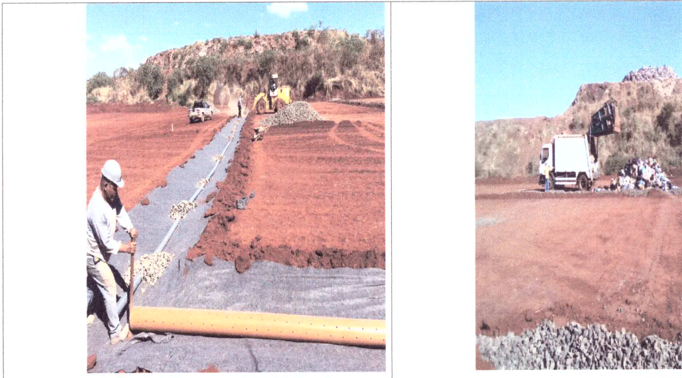
Foto: Plataforma de disposição de Resíduos Domiciliares construída em 2017.
