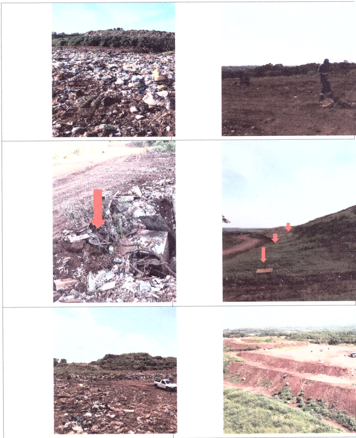
FOTO: Operação Aterro Sanitário Comparativo
