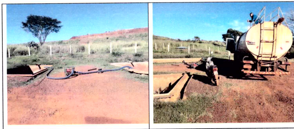
Foto: Armazenamento e retirada do chorume para encaminhamento a ERPAI 2019
