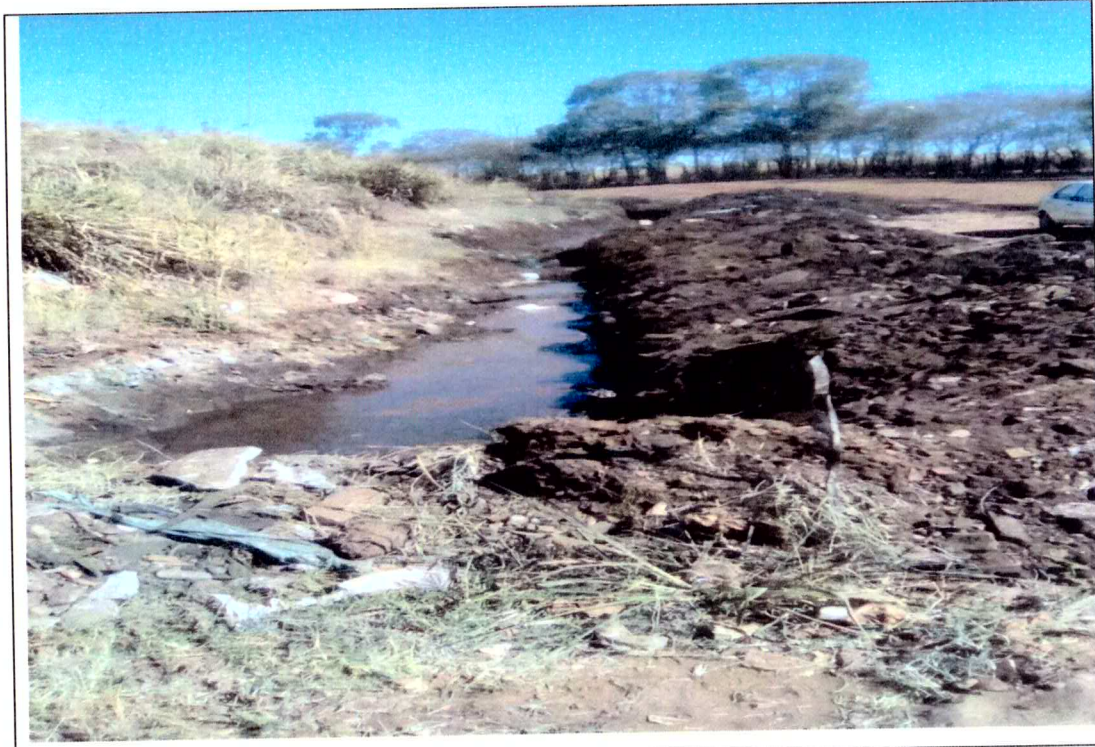
Foto: Desobstrução rede chorume 2017
