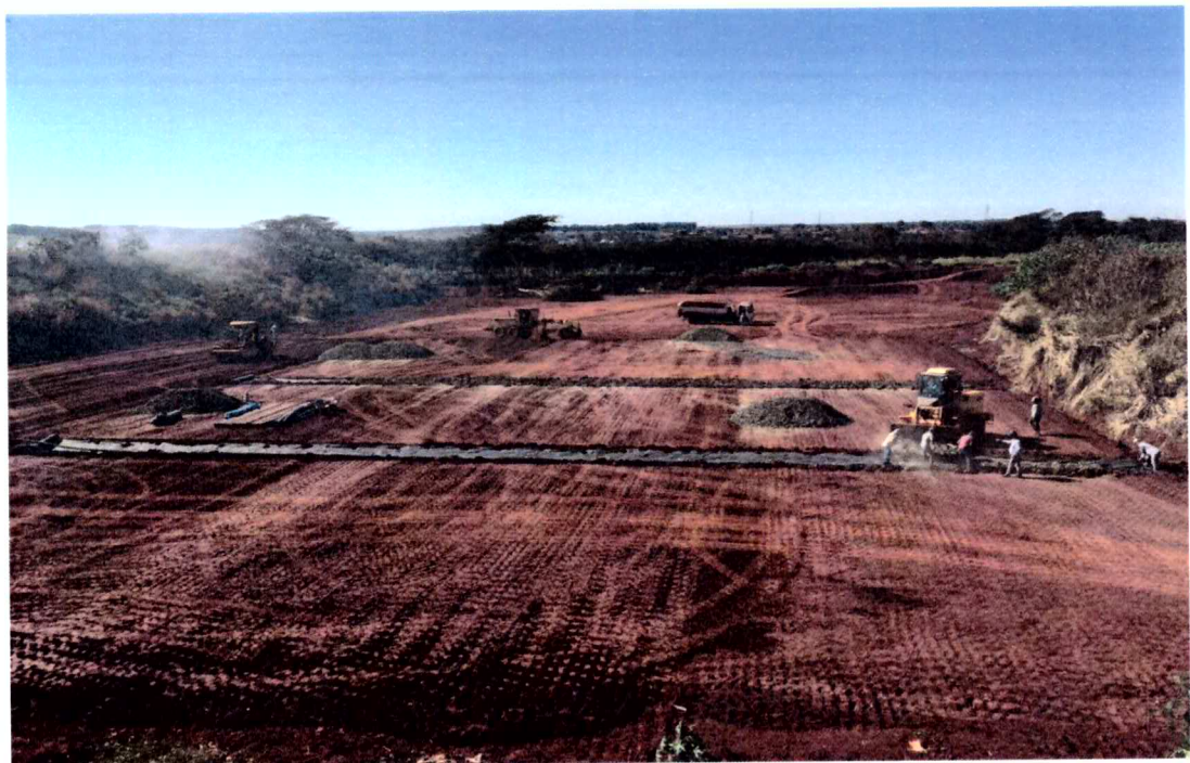
Foto: Plataforma de disposição de Resíduos Domiciliares construída em 2017.
