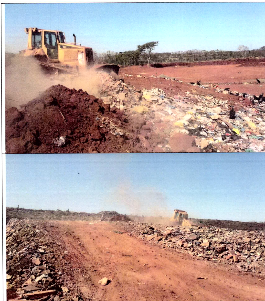
Fotos: Cobertura diária sendo realizada com RCC segregado 2017
