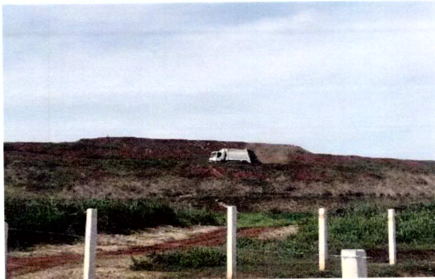
Foto: Talude em operação 2019
