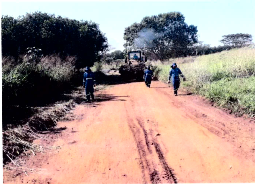
Foto: Vias de acesso internas 2019
