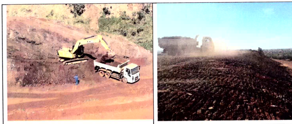
Foto: Parte da etapa de finalização dos taludes encerrados 2019
