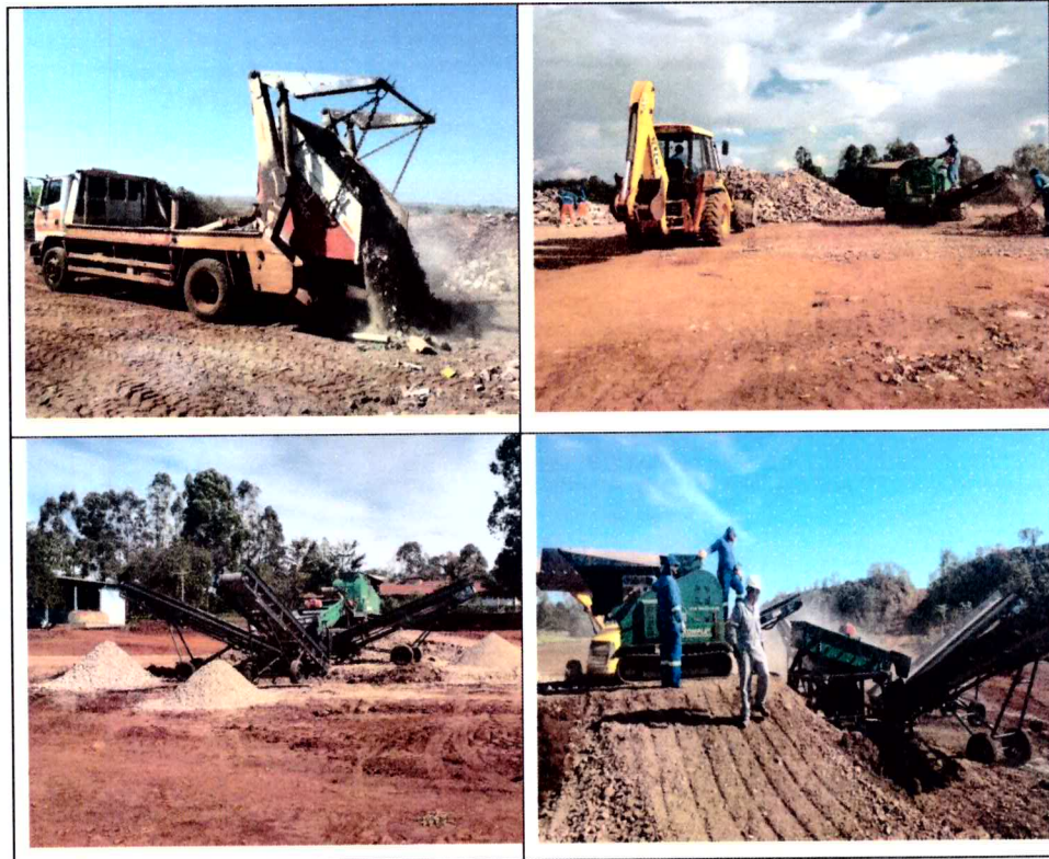
Foto: Processo de segregação e reciclagem do resíduo da construção civil 2019
