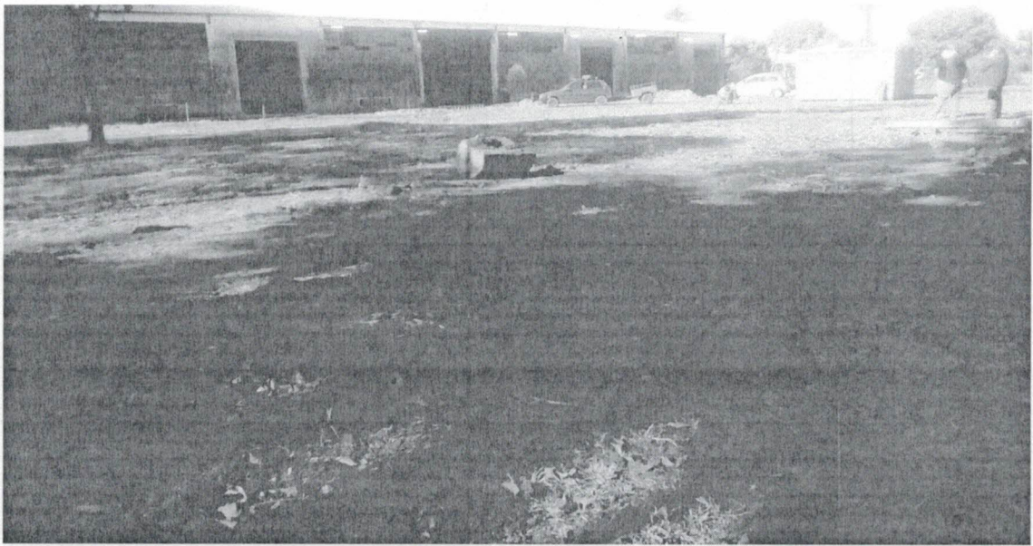
Foto: Vista área externa obras fase inicial.
