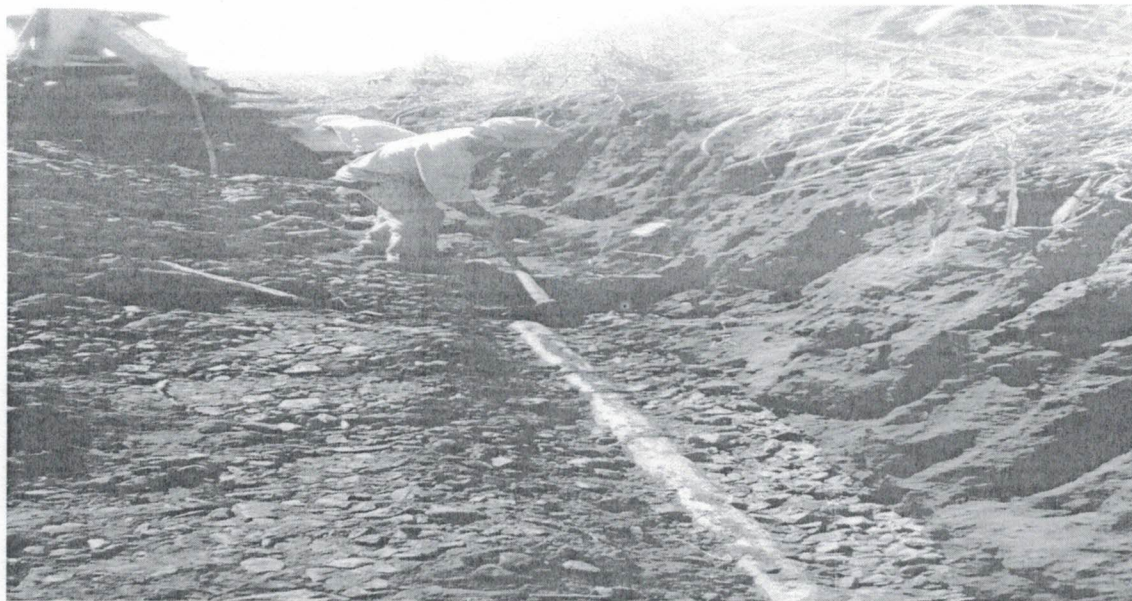
Foto: Correção do Sistema de drenagem de chorume
