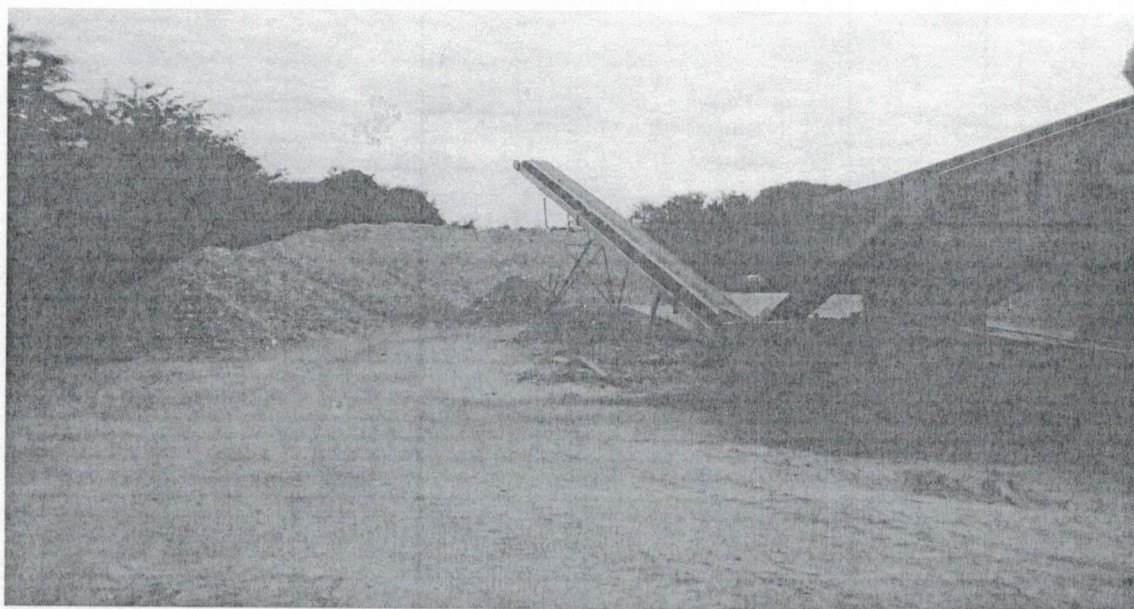
Foto: Usina privada de Reciclagem de RCC em São José do Rio Preto.
