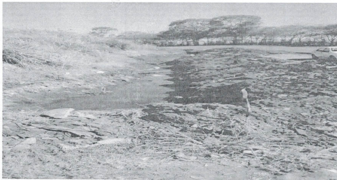
Foto: Correção do Sistema de drenagem de chorume
