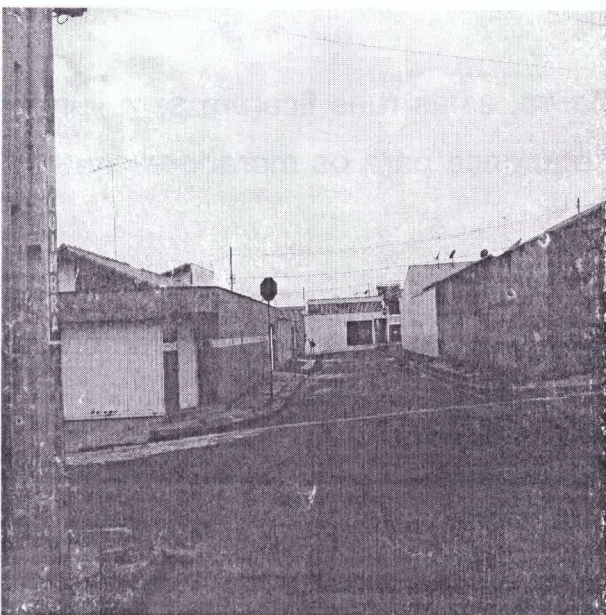
Vista da Rua Coimbra entre Ruas Lion e Lisboa
