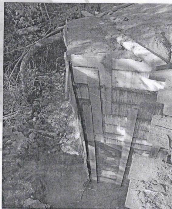
Foto 04 – Vista panorâmica da inferior da ponte
