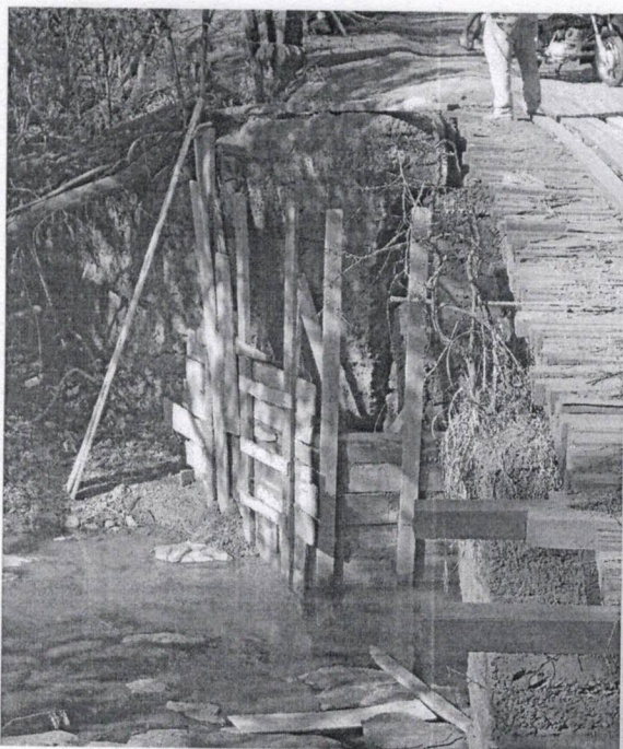
Foto 01 – Vista panorâmica da inferior da ponte
