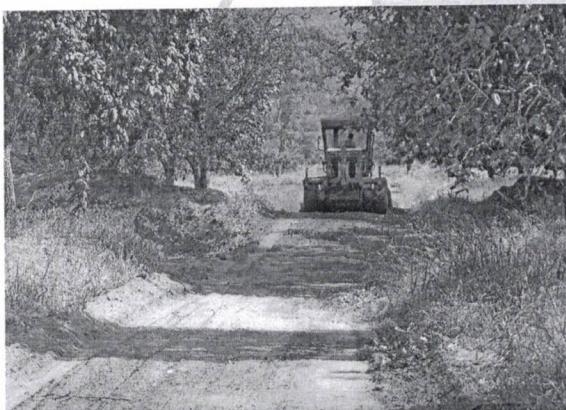
Foto 05 - Restauração da Estrada São Lourenço
