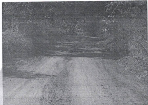
Foto 02 - Restauração da Estrada São Lourenço
