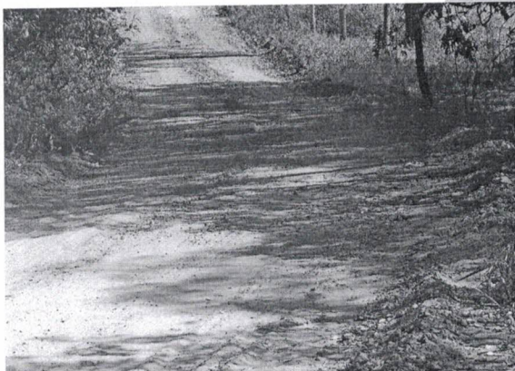
Foto 03 - Restauração da Estrada São Lourenço
