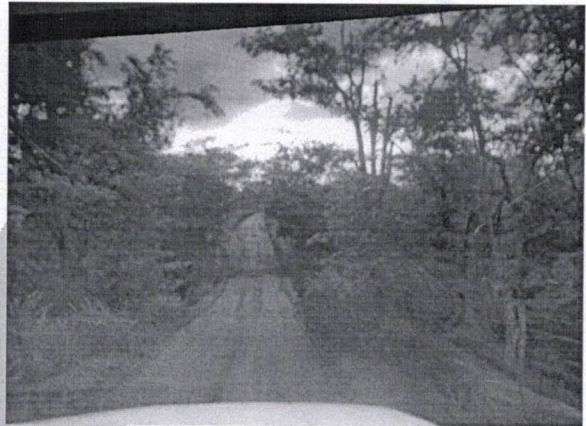
Foto 02 - Restauração da Estrada São Lourenço
