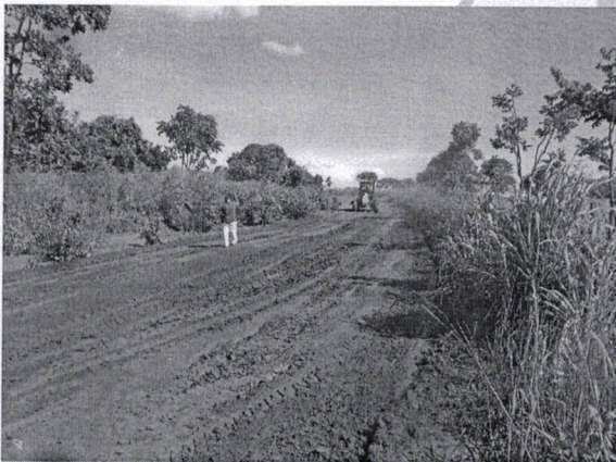
Foto 03 - Restauração da Estrada São Lourenço
