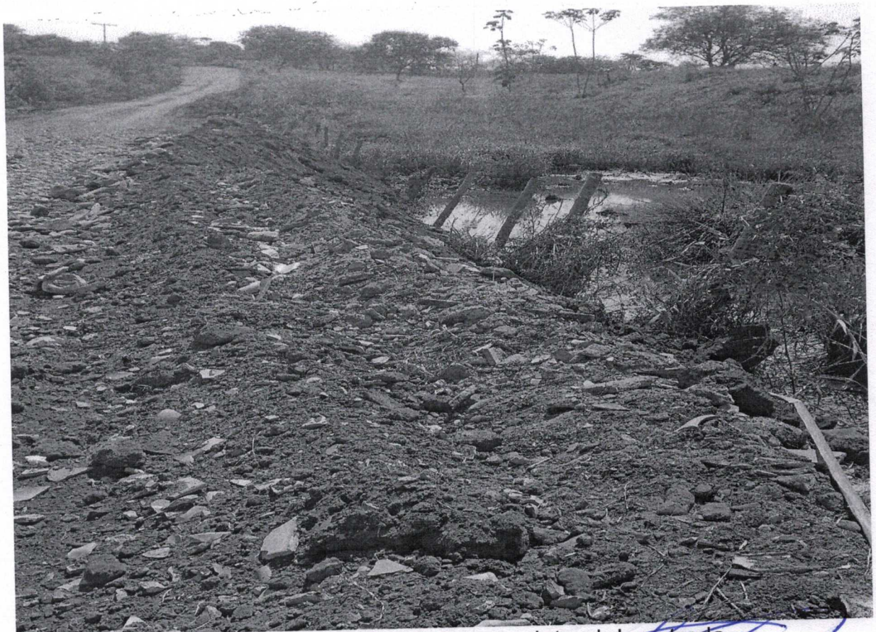
Foto 03: Construção do talude de sustentação, lateral da estrada.
