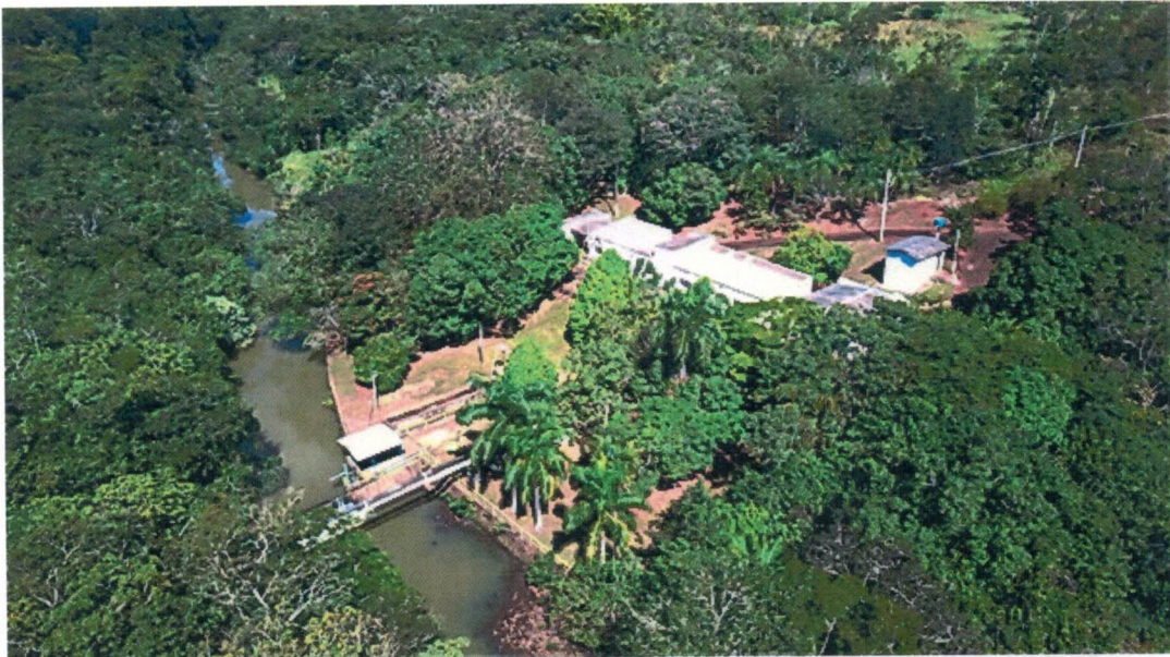
Captação do Ribeirão São Lourenço
