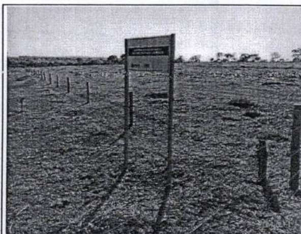
Foto 6: Empresa ARQGRAPH realizando serviços de instalação da Placa de Obra no imóvel participante do Programa AMIGOS.
