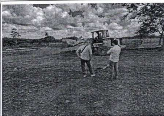
Foto 3: Empresa ARQGRAPH e SAE realizando vistoria nos serviços de construção dos terraços em nível no imóvel rural.
