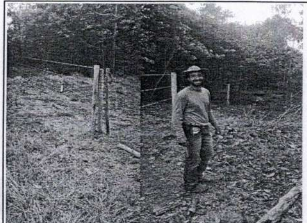
Foto 4: Empresa ARQGRAPH realizando serviços de confecção de 30 metros/lineares de cerca na margem esquerda do Córrego do Mato Grosso.
