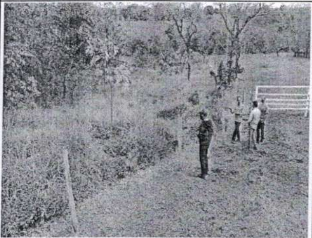
Foto 1: Empresa ARQGRAPH e SAE realizando vistoria em serviços de coroamento, aceiro em cercas e combate a formigas.
