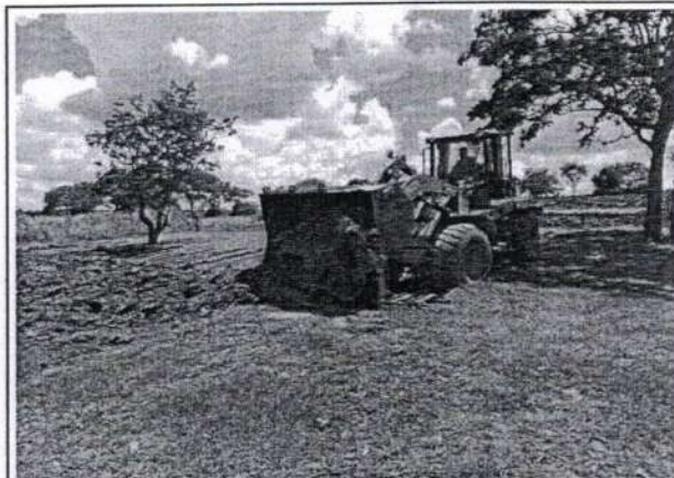
Foto 2: Empresa ARQGRAPH realizando a construção dos terraços em nível no imóvel rural.
