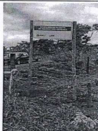
Foto 6: Empresa ARQGRAPH realizando serviços de instalação da Placa de Obra no imóvel.
