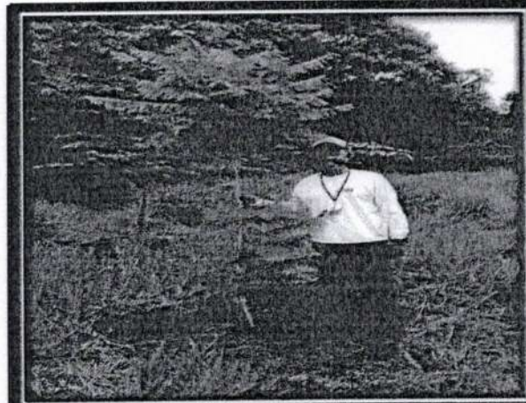
Foto 4: Empresa ARQGRAPH realizando serviços de manutenção, coroamento, adubação e combate a formigas
