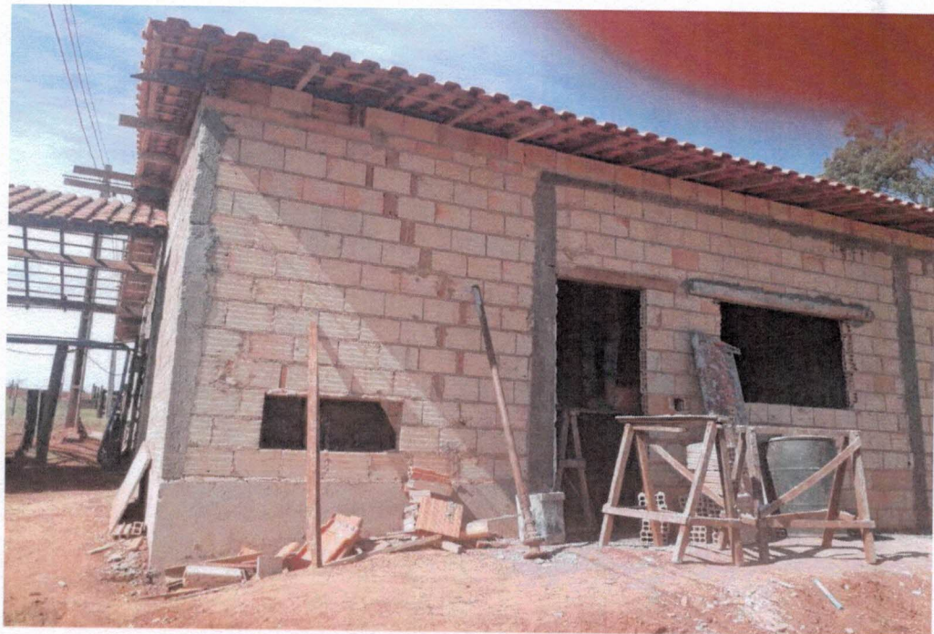
Foto 19: Construção da Queijaria – Queijos Minas Artesanal UAI SO
