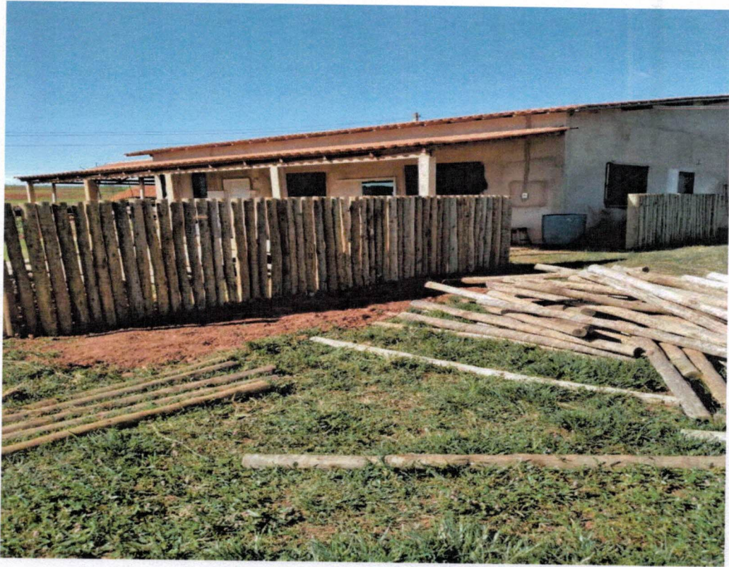
Foto 20: Queijaria UAI SÓ. Terminando a construção
