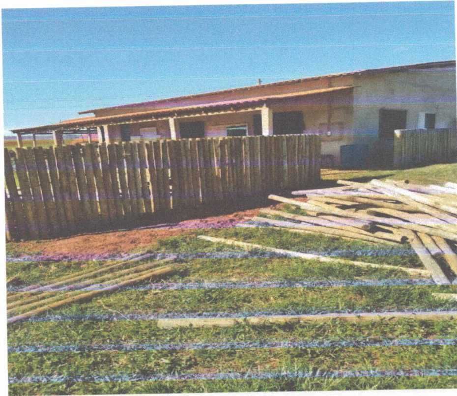
Foto 5: Queijaria UAI SÓ. Terminando a construção .
